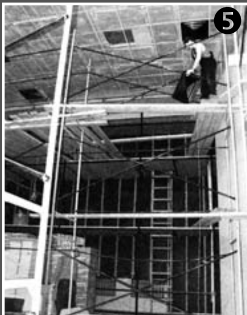
5 Идет реконструкция зрительного зала.
